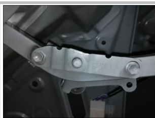
2.5 需要一个人扶助尾门,使其保持开门状态。然后将气弹簧一侧(右侧)原车弹簧取下;取下原车弹簧后,将原车用于固定气弹簧的支架拆卸下来
